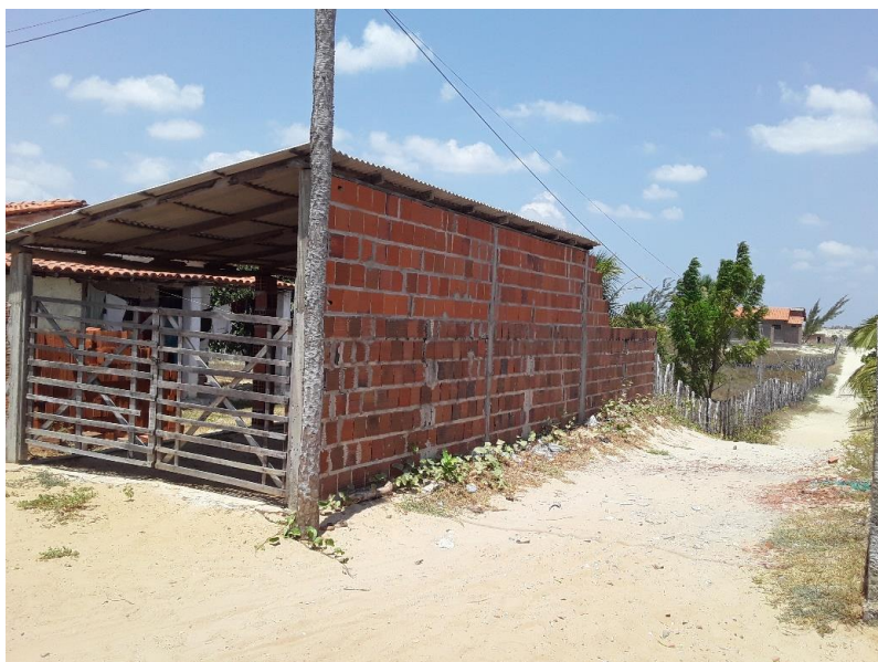
Imagem 07: Rua no lado esquerdo do imóvel (observando do imóvel para a Av. Principal). Visão da garagem de Antônio José Galeno do Nascimento (“Dedé”).
